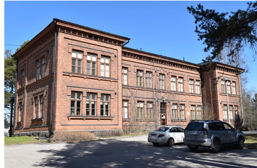
Kuva: Kaksikerroksinen tiilirakennus valmistui 40 vuodepaikan sairaalaksi vuonna 1891. U-volyyminen hahmo ja tiilikoristelu yhdistävät sairaalan rakuunakasarmien rakennustapaan, mutta vain sairaalassa on käytetty 2-3 ikkunan ryhmitystä.
