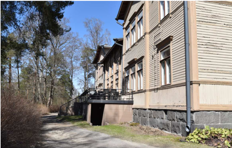
Kuva: Rakennuksen vuoraustapa, listoitus ja ikkunamalli palautuvat 1800-luvun lopulla suosittuun uusrenessanssiin. Alkuperäinen kerhon avoterassi oli nykyistä pienempi. Terassin alapuolelle on sauna.
