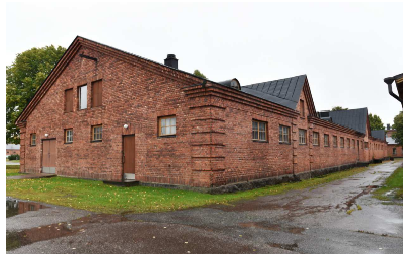
Kuva: Pitkän tiilirakennuksen räystäslinjassa on profiilimuuraus, nurkat on korostettu harkotuksella ja katolla on lunetti-ikkunoita. Pitkän kattolinjan katkaisevat jyrkkäharjaiset poikkipäädyt, joista keskimmäisen kohdalla, molemmilla pitkillä sivuilla, on harkotusten reunustama sisäänkäynti.
