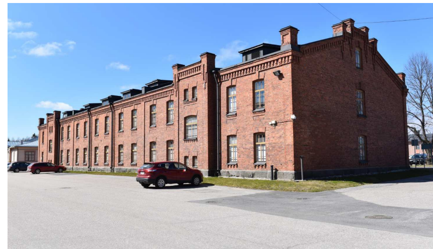
Kuva: Pitkillä sivuilla on kaksi seinälinjasta ulkonevaa risaliittia, jotka osoittavat portaikkojen paikan. Syvärunkoisen rakennuksen päädyissä on goottilaishenkiset sakaramuurit ja räystään alla kulkee hammasfriisi. Ikkunat ovat samankokoisia molemmissa kerroksissa, mutta koristelultaan erilaisia.
