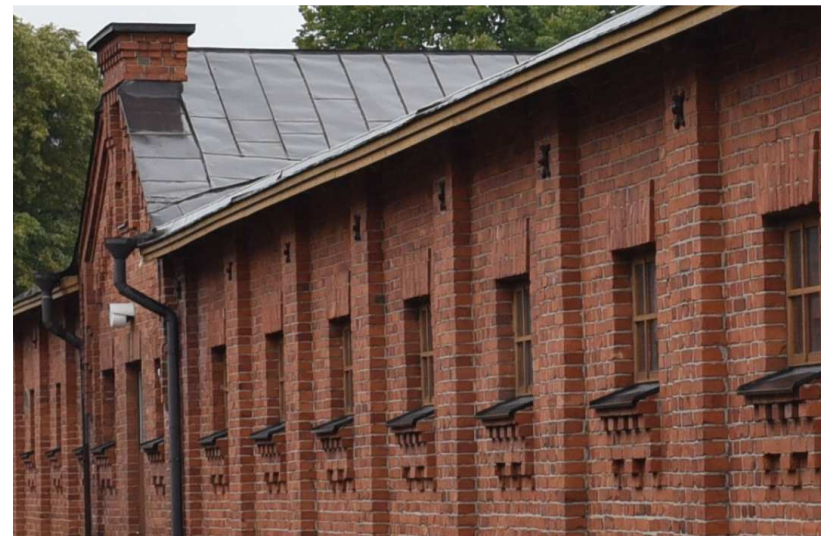
Kuva: Venäläiskauden tallirakennusten julkisivuja leimaa struktuuri, joka syntyy kapeista liseeneistä ja pienistä vaakaikkunoista, joiden alaosassa on koristeellinen muuraus. Ristipäädyn harjalla on sakara. Räystäään alla on puiset profiloidut katonkannattajat.
