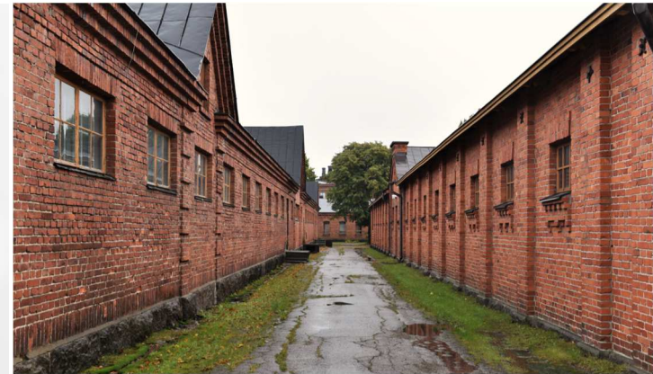
1920-luvun tallirakennus nro 19.
